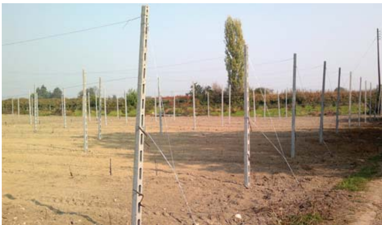
Εικόνα 2. Εγκατάσταση στήριξης δένδρων με διάτρητες τσιμεντοκολώνες, με 4 σύρματα, σε οπωρώνα που προορίζεται για Μονόκλωνες κερασιές.
