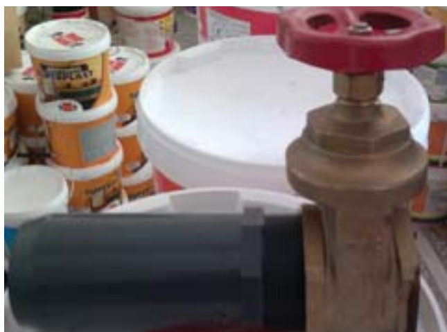
Εικόνα 5. Οριχάλκινη βάνα 2,5" και είσοδος γραμμής άρδευσης.
