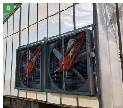
Εικόνα 3. Η τοποθέτηση α) ανεμιστήρων και β) κυκλοφορητών αέρα βοηθούν στο δροσισμό του δικτυοκηπίου.
